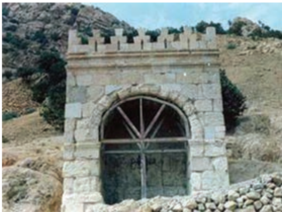
▲ شکل ۴-۷۱ قوس سنگی (طاق گرا در مسیر کرمانشاه به سر پل ذهاب)
