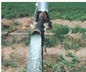
▲ شکل ۹-۲ انتقال آب از طریق لوله
