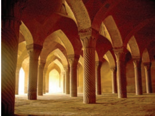
▲ شکل ۴-۶۹ قوس های آجری (مسجد وکیل شیراز)
