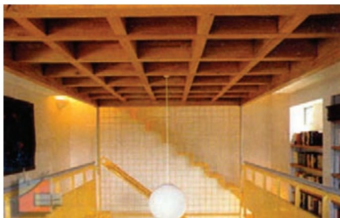
◀ شکل ۱-۵۹- سقف کاذب مشبک چوبی
