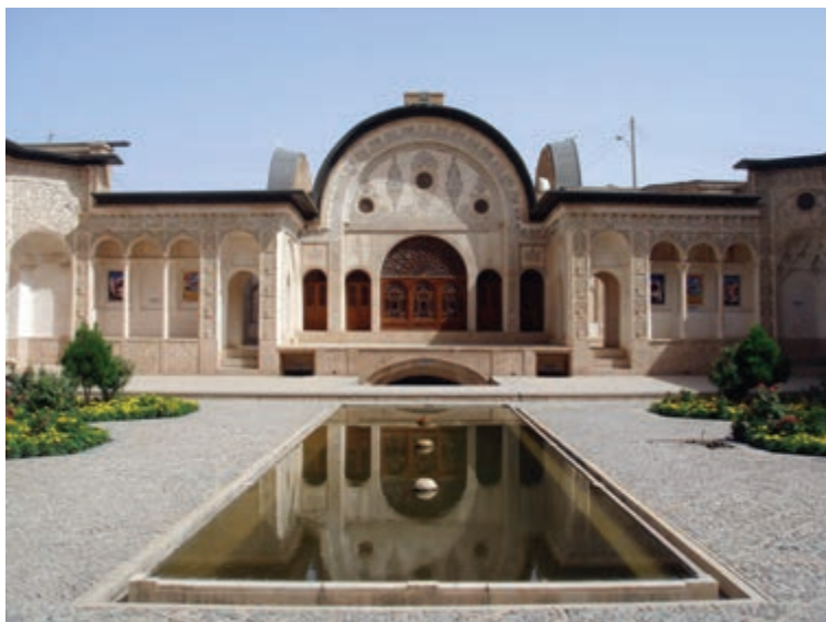
شکل ۲۶-۴ خانه طباطبایی ها در کاشان (قوس نیم دایره)
