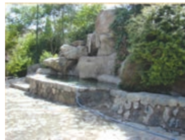
▲ شکل ۳-۴۷ اجرای پیاده‌رو با رویه‌ی سنگی
