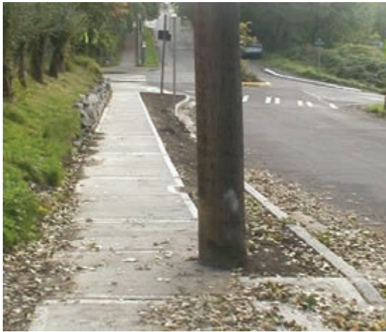
▲ شکل ۳-۴۰ به کارگیری قطعات مجزا در کف‌سازی
