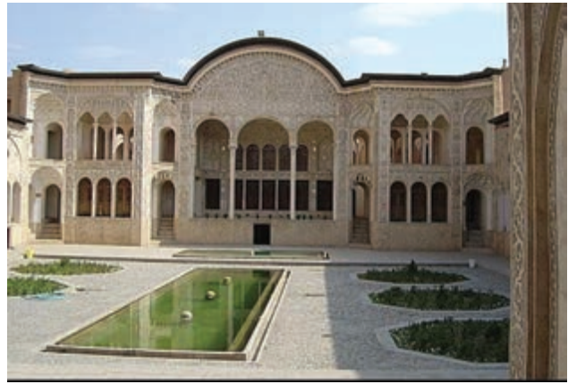
▲ شکل ۱۱-۴ خانه طباطبایی‌ها در کاشان (انواع قوس‌های مدور)
