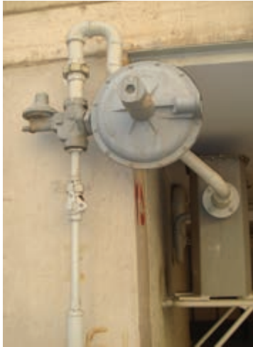
▲ شکل ۲-۹۳ علمک و رگولاتور روی آن
