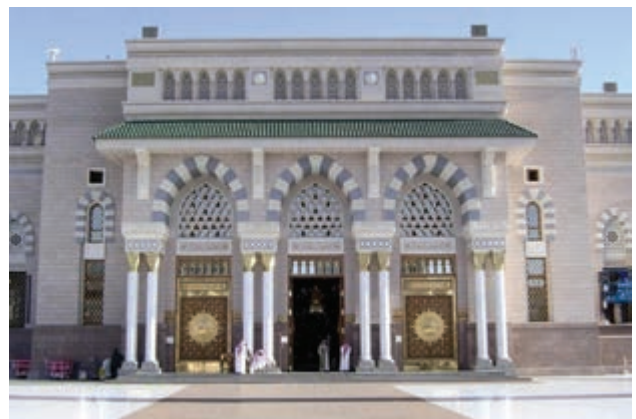
▲ شکل ۴-۷۰ قوس های سنگی (مسجد پیامبر)
